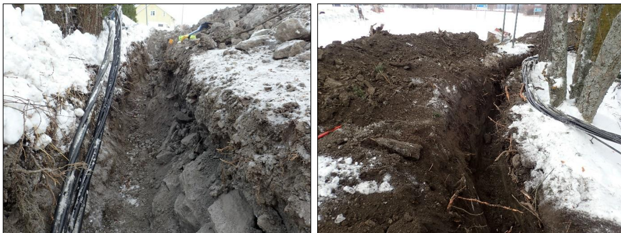
Vasen: Risteysalueen itäpuolen kivistä täyttökerrosta. Länteen. Oikea: risteysalueen itäkulma, missä kaapelioja kaartaa etelään. Sorkkalantien varressa ei ollut samanlaista lohkokivistä täyttökerrosta kuin Anian rantatien varressa. Pohjoiseen.
